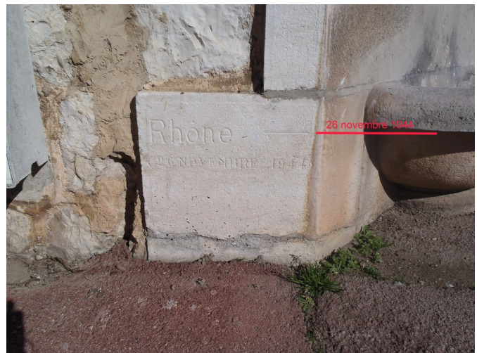
Détail repère de la crue du 26 novembre 1944 (photo DDT26)
