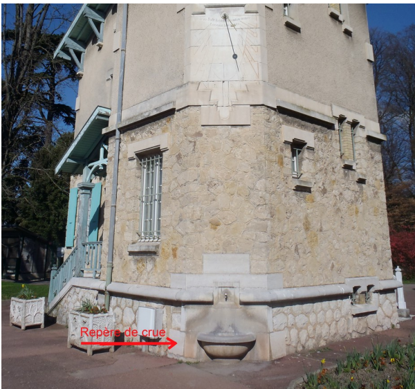
Position du repère de crue sur la maison du gardien du Parc Jouvet (photo DDT26)
