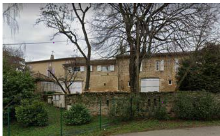
Vue sur l'habitat résidentiel situé chemin de Paillassier (enjeu patrimonial)
