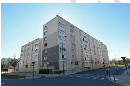
Démolition prévue de l'immeuble Rousset (62 logements)
