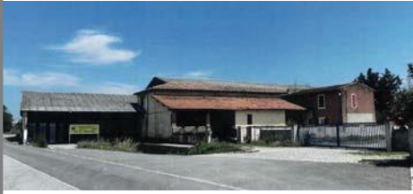
Vue sur le site de renouvellement urbain (entreprise Chantreau) permettant l'accueil d'une résidence services seniors
