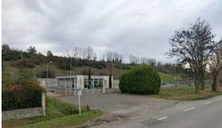
Vue sur les équipements publics (bassin de rétention)
