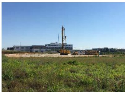
Vue sur la ZA en cours d'aménagement
