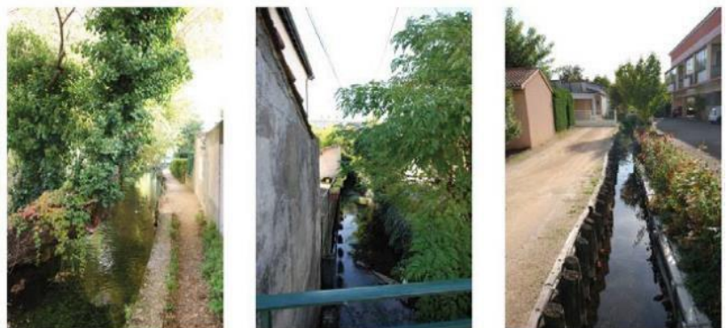
Canaux aménagés dans le quartier de Chateouvert, dans les faubourgs de Valence.
