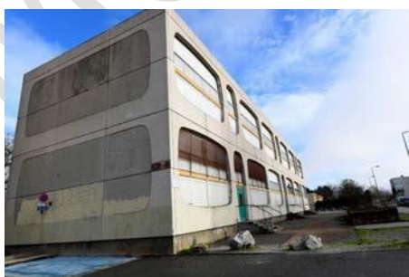
Démolition prévue de l'immeuble Vercors (24 logements)
