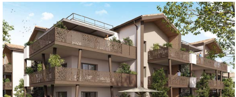
Soléa - Valence Route de Malissard
